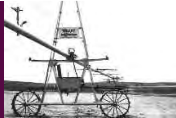
1952 | EN EEUU ZYBACH PATENTÓ EL SISTEMA DE RIEGO PIVOT CENTRAL CON AVANCE POR PRESIÓN DE AGUA | EN ARGENTINA SE INTRODUJERON RECIENTE EN 1970 | 6 A 7 KG/CM 2 DE PRESIÓN DE AGUA Y ASPERSORES TIPO MARTILLO
